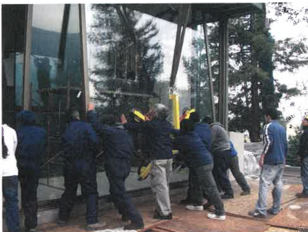
Instalación cristal jumbo
