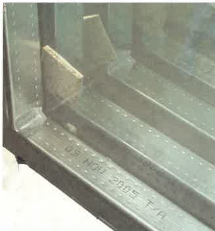
Detalle Doble Vidriado Hermético
