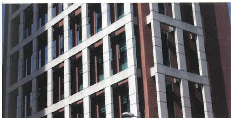
Obra: Hotel Holiday Inn Arquitecto: Ruiz Tagle - Vicuña Arq. Cristal: Control Solar en DVH Las Condes, Santiago
