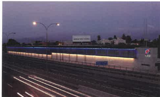
Obra: Oficinas Autopista Central Arquitecto: + Arquitectos Santiago
