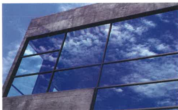
Obra: Gimnasio Neo Sport Cristal: Laminado Acústico 6.8 mm Atenuación: 35 dB Peñalolen, Santiago
